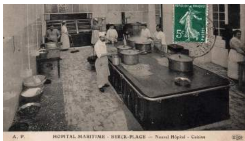
A. P. HOPITAL MARITIME - BERCK-PLAGE — Nouvel Hôpital - Cuisine
